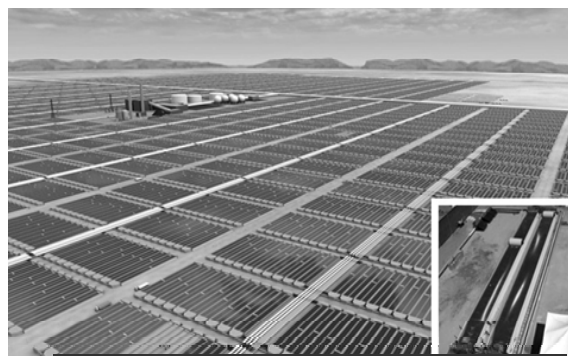
Рис. 3. Промышленное выращивание микроводорослей в открытых прудах
