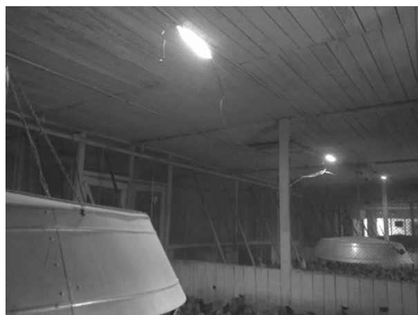
Рис. 5. Резонансная система освещения цеха для содержания птицы (птицефабрика «Кучинская», 2010 г.)
