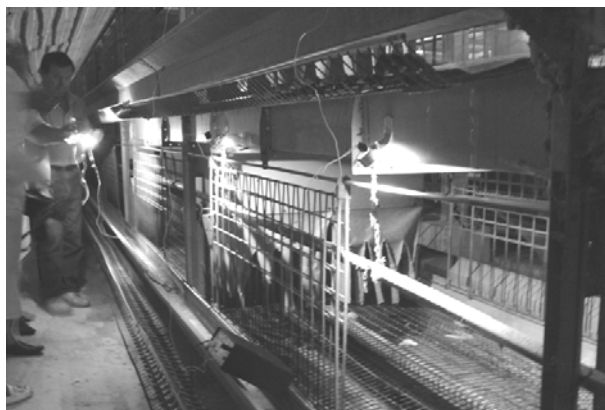
Рис. 4. Резонансная система освещения цеха для содержания птицы (птицефабрика «Птичное», 2009 г.)
